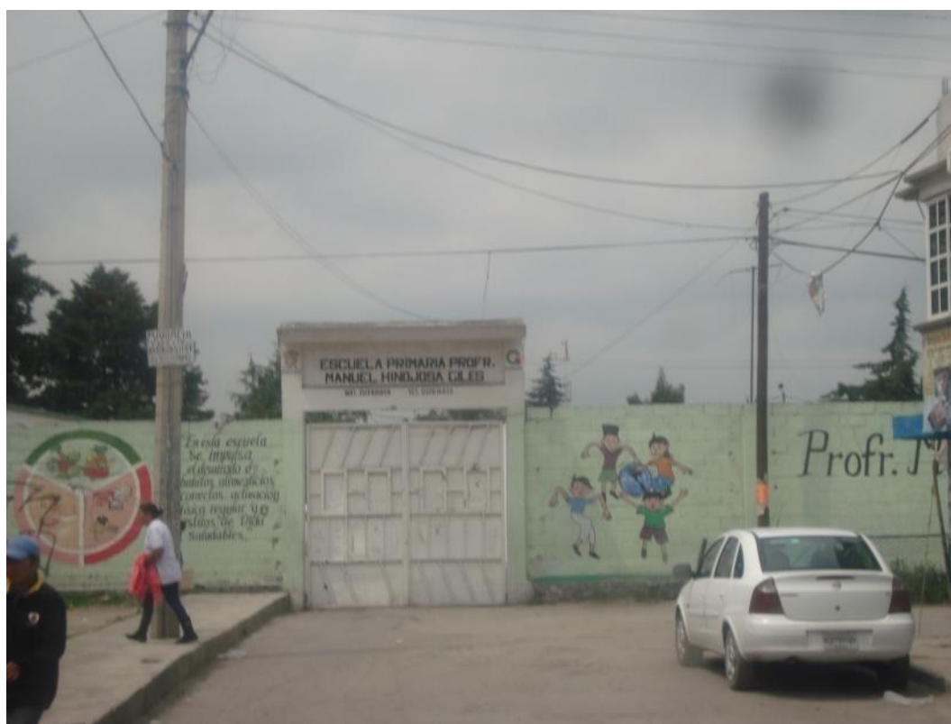
Imagen 1. Escuela primaria Manuel Hinojosa Fuente: Trabajo de campo 2013.
