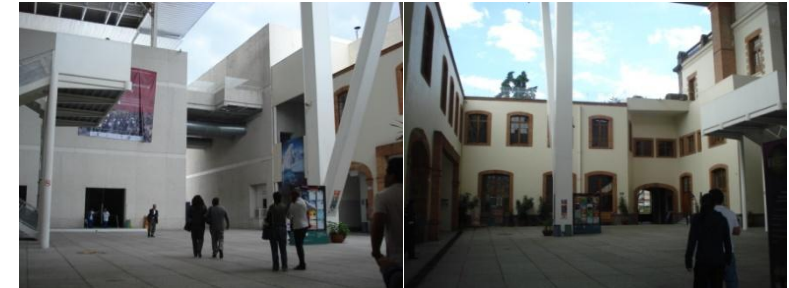
Imagen 82 Vista Norte (izquierda) y Sur (derecha) del Patio central del MUMCI. (Solano, 2012)
