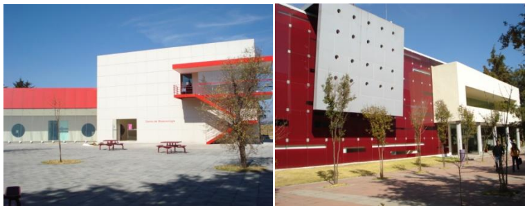
Imagen 56 Paradoja: Variedad de estilos arquitectónicos generan una barrera virtual con el CEDETEC desasociándola con el resto del Campus. (Solano, 2010)
