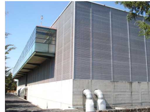
Imagen I: Fachada Norte de CEDETEC Torre Norte, ejemplo de arquitectura abstracta
