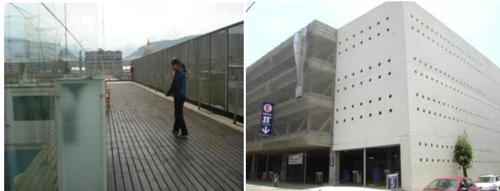
Imagen 90 Translucidez: Barrera virtual que limita pero no separa. Lámina perforada en la terraza (izquierda) y malla de acero con muros de concreto perforado en fachada (derecha). (Solano, 2012)
