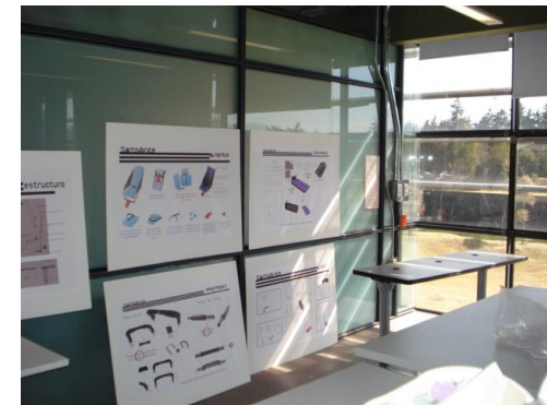
Imagen 6: Muros divisorios de cristal y cancel de piso a techo en talleres de la Escuela de Arquitectura.
