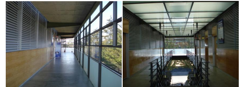
Imagen 64 Lo inevitable del destino, evidenciado en el emplazamiento longitudinal, sumado a la modulación y neutralidad del CEDETEC. (Solano, 2010)
