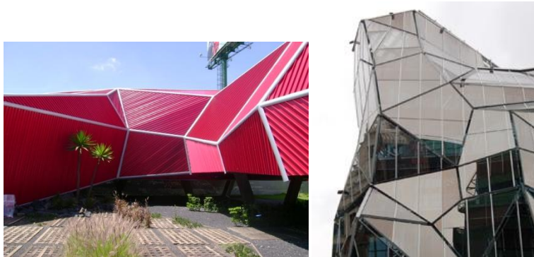
Imagen 75 Recursividad, Juego y Homogeneización de la arquitectura de pliegues. Detalle del Museo del Chocolate de Rojkind en México (izquierda) y Sede del Departamento de Sanidad Vasco de Coll-Barreu Arquitectos en España (derecha). ( http://arquitecturainteligente.wordpress.com , 2007 y http://www.construarea.com , 2008
