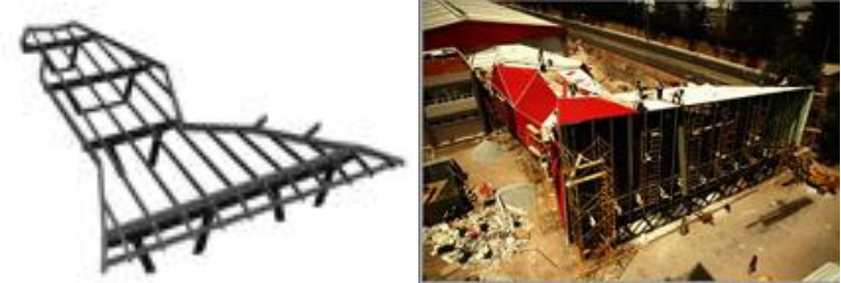
Imagen 66 Estructura del Museo (izquierda) y proceso de colocación de cubierta metálica acanalada (derecha.) ( http://www.skyscrapercity.com , 2007)
