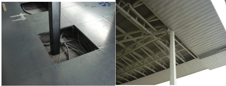
Imagen 96 Paradoja: Instalaciones y estructuras que si se ocultan. Piso con instalaciones ocultas (izquierda) y estructura oculta bajo un falso plafond (derecha). (Solano, 2012)
