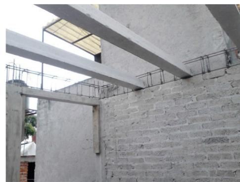
Las viguetas apoyadas sobre los muros que hayamos definido como los cargadores de nuestra losa, introduciéndose sobre las cadenas de cerramiento o bien se colocan sobre las traves de forma manual
