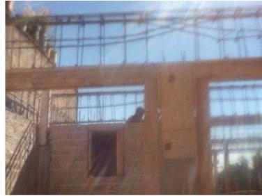
Se colocan puntales y largueros de apoyo y nivelación. y se retiran a los 7 días del colado de la capa de compresión. Se colocan puntales de 4" x 4" a cada 1.50m y largueros de la misma sección a cada 1.60m para servir de apoyo provisional a las
