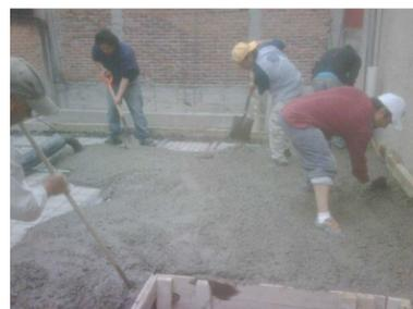
Se tapan los huecos de las bovedillas de los extremos y/o aquellas que se hayan recortado para ajustar el claro. Se mojan perfectamente las viguetas y bovedillas y se cuela de 3 a 5 cm de concreto según la malla utilizada. Se recomienda mojar las bovedillas para obtener una mayor adherencia con la
