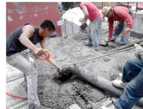
Nota: cuando se haga un colado mediante concreto premezclado se recomienda que el vaciado del concreto sea sobre las cadenas o trabes
