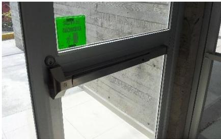
Figura 2.12.- Barra de pánico en puerta \*. Fuente: foto del autor.
