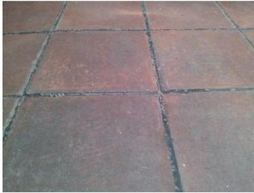
Figura 2.14.- Piso antiderrapante \*. Fuente: foto del autor.
