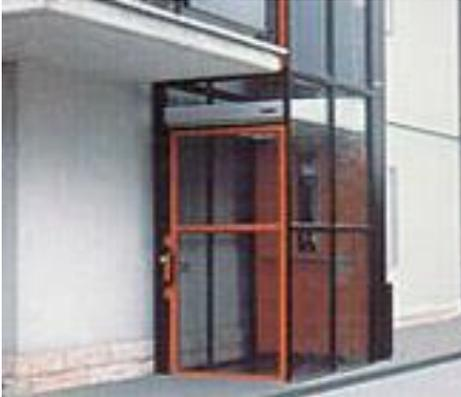
Figura 3.32.- Plataforma de elevación vertical. Fuente: <http://www.tecnum.net/catalogo.htm> Consultada el 19 de mayo del 2013
