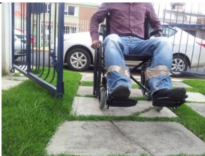
Situación: Las ruedas de la silla se bloquean en la junta de los bloques de concreto.
