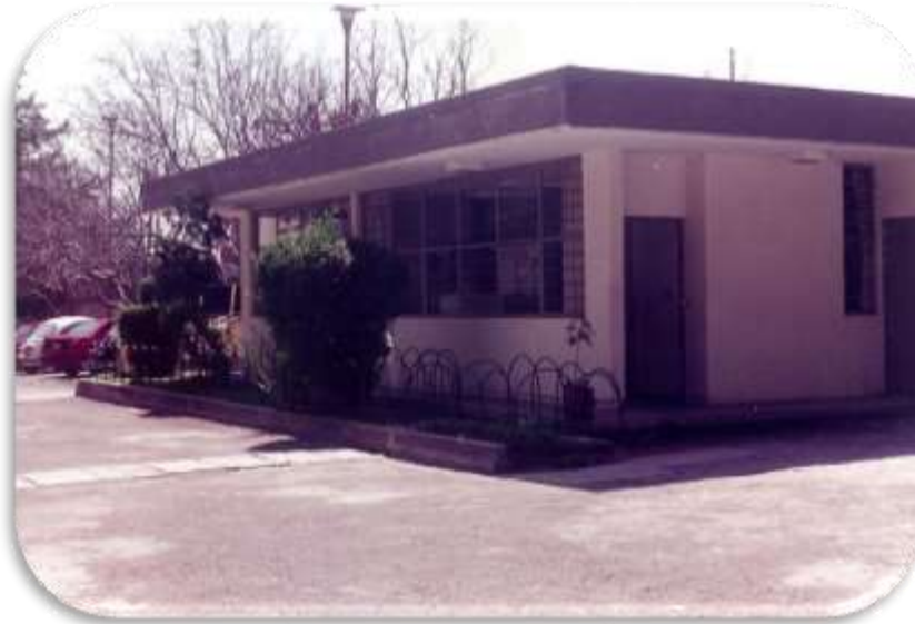
Oficinas administrativas de la Coordinación de Servicios de la Facultad de Química a partir de 1992, localizadas hacia el sur de instalaciones del campus Toluca.
