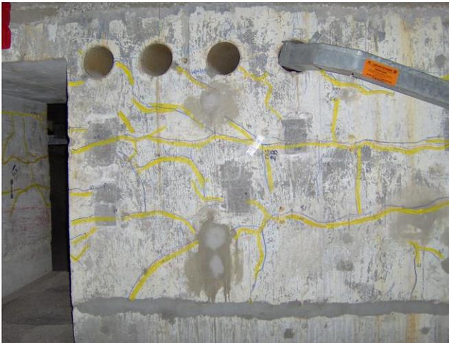
**Figura I.4.** Agrietamientos observados en una de las pilas del Puente (en el interior de la calzada), en visita realizada en agosto de 2007.
