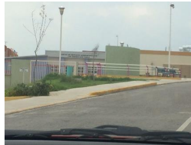
Imagen 14: Centro de servicios administrativos Los Héroes Tecámac
